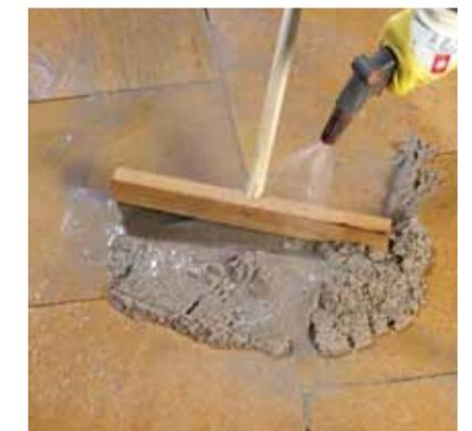
**TERRAMENG „FesteFuge“** mit Hartgummi-schieber und weichem Wasserstrahl gründlich in die Fugen einschlämmen.
