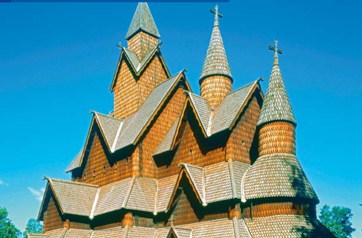
Die Stabkirche Heddal (Norwegen), im 13. Jhd. erbaut, ist ein sichtbares Zeichen für dauerhaften, konstruktiven Holzschutz.
